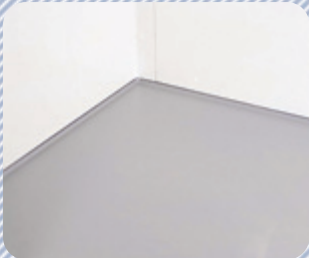
› Totale assenza di profili, basamento a vasca arrotondato
